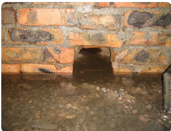
Замкнутое пространство подвала: опасности не видны глазом
