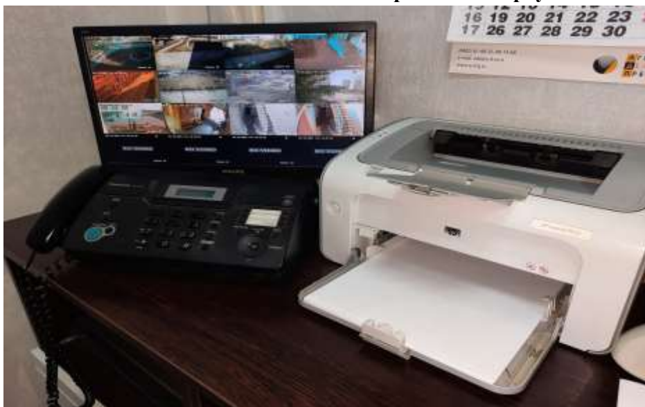
Фото № 27: Система фотофиксации на объекте в кабинете заведующего 1 корпус
