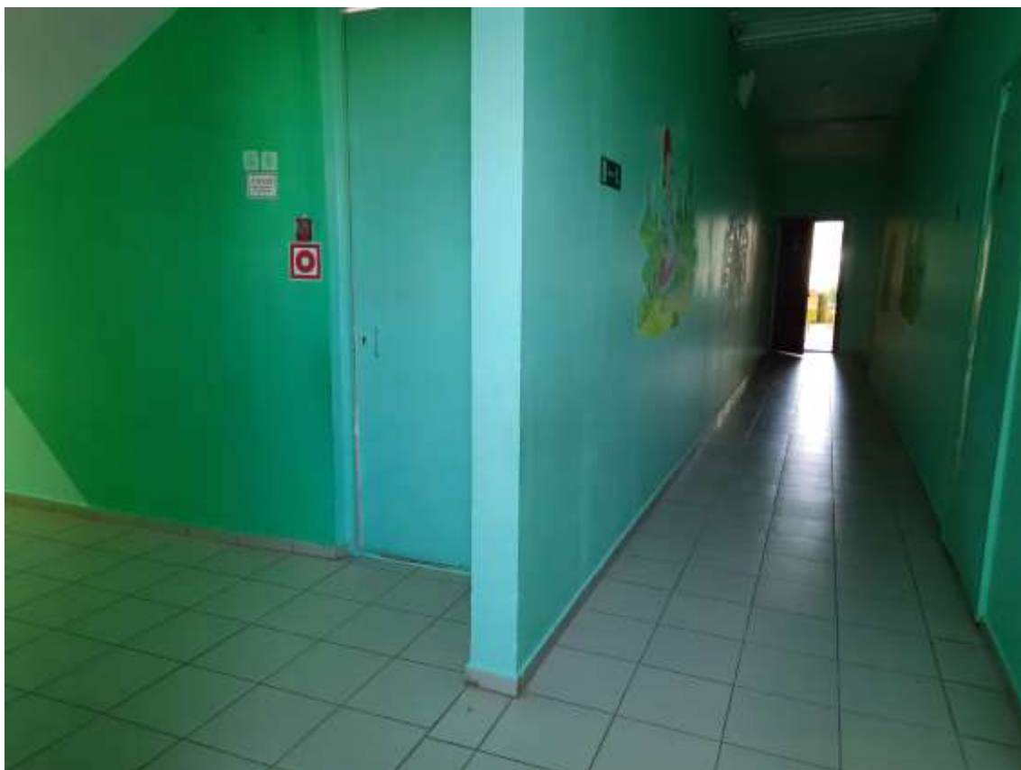
Фото № 16: Путь движения внутри здания 2 этаж, корпус 1
