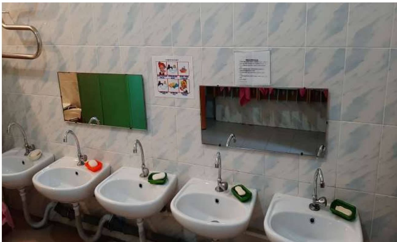
Фото № 23: Санитарно-гигиенические помещения 2 корпус: Умывальная комната
