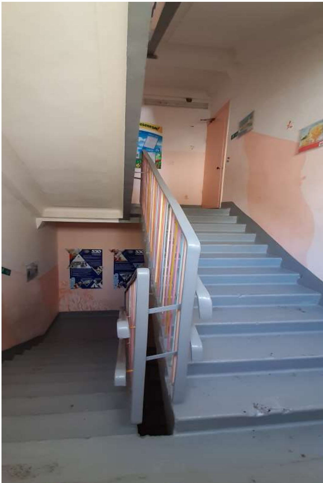
Фото № 16: Путь движения внутри здания 2 этаж, корпус 2
